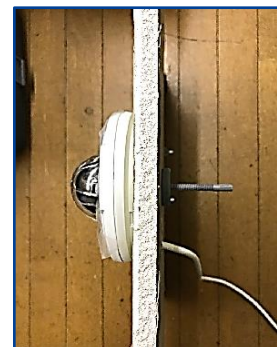
④カメラを固定具で固定する
