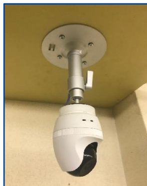
⑩画角を調整して完了 ※画角調整は映像を見ながら実施してください。
