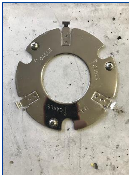
④取付金物を設置面に固定する
