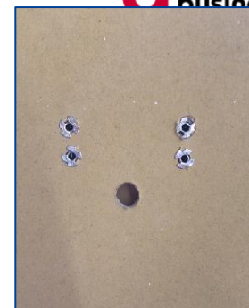
⑤ボードアンカーを取り付ける ※サンプルではネジ径M4の開脚式のボードアンカーを使用しています。
