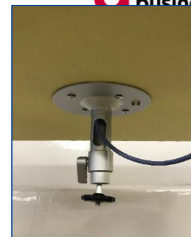
⑤LANケーブルを通しフィクサーを固定する。
