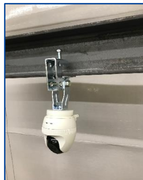
⑦カメラをH鋼に固定しLAN(UTP)ケーブルを接続する
