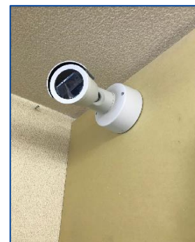
⑬完了 ※画角調整後はT10ビスを確実に締めてください。
