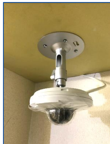
⑥カメラを設置する ※設置後は必ずフィルムを剥がしてください。
