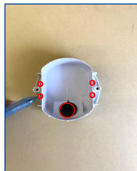
③ベースを設置面にあて墨出しする。 ※固定穴○印4か所、通線口○印1か所
