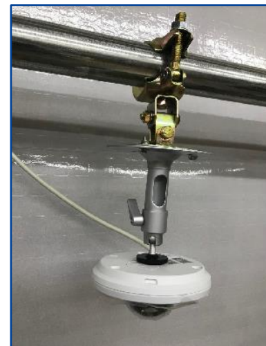
⑤カメラを設置する ※設置後は必ずフィルムを剥がしてください。
