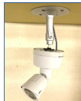
⑧フィクサーにカメラを取り付ける。
